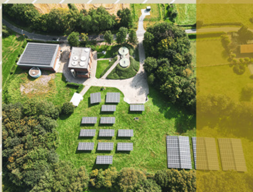
Solaranlagen an der Kläranlage und am Wasserwerk des Trink- und Abwasserverbandes Bad Bentheim, Schüttorf, Salzbergen und Emsbüren
